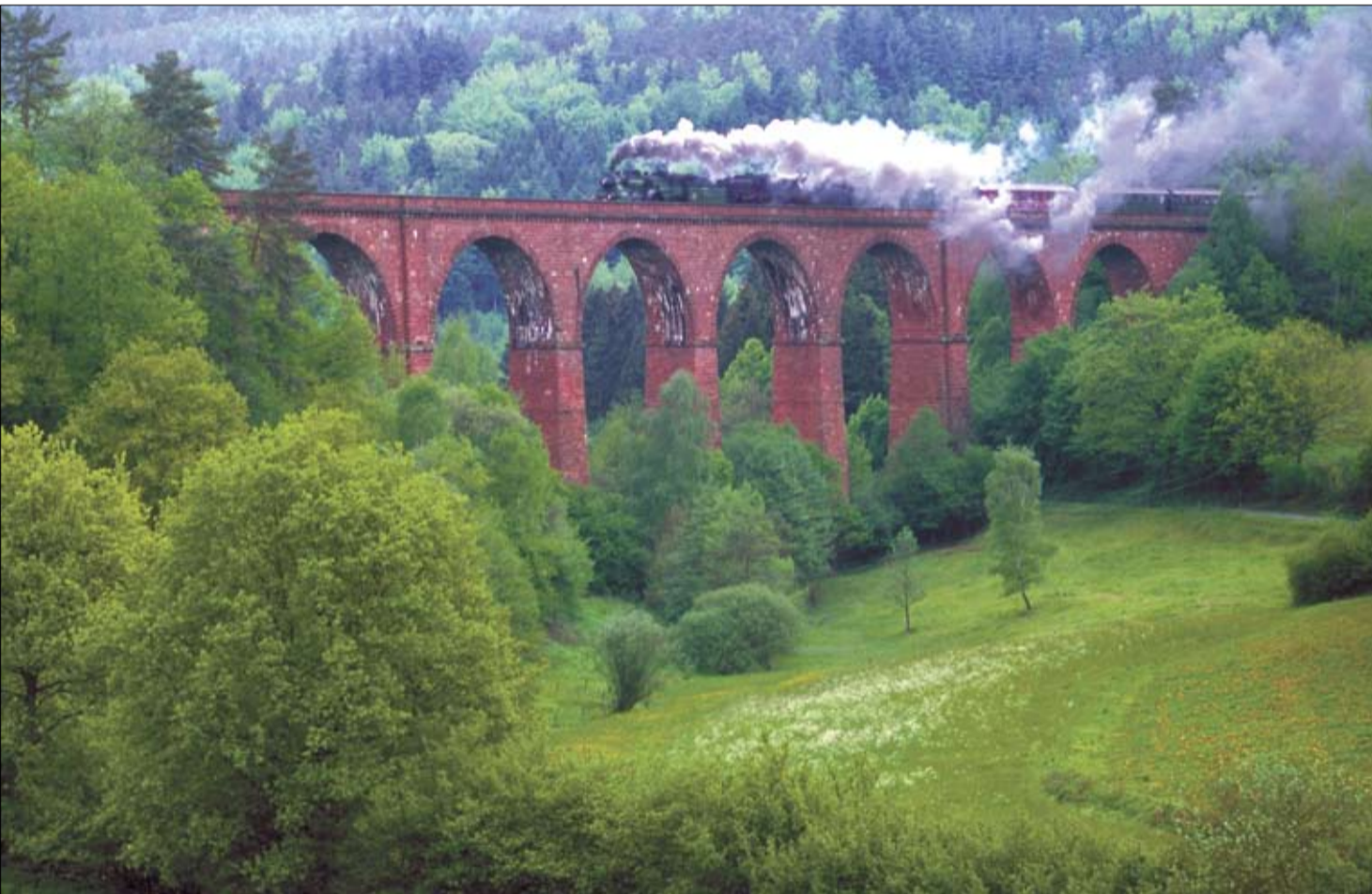
Volldampf: Das Himbächel-Viadukt zählt im wahrsten Sinne des Wortes zu den Höhepunkten einer Fahrt auf der Odenwald-Bahn. (Foto: Gunter Hartmann)
